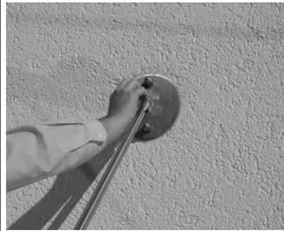
Komponente CL03 wird in Komponente CL01 eingeschoben und mit dem Edelstahlbolzen Position P09 befestigt. Anschließend wird der Bolzen mit dem zugehörigen Sicherungsring gesichert.
