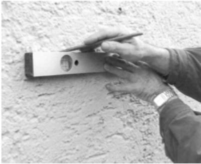
Mit geeigneten Messmitteln ist die genaue Lage der Befestigungspunkte für die Wandanschlusskonsolen Komponente CL01 und CL02 einzumessen.
