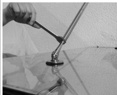
Das Vordach wird durch das Einstellen der Komponente CL03 ausgerichtet.
