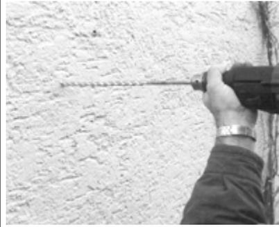
Die Bohrungen sind mit geeigneten Bohrwerkzeugen, für die jeweiligen Befestigungsmittel, z.B. Sicherheitsanker, Verbundanker oder Injektionsdübel - abhängig von der Art der Gebäudewand - (gem. Herstellerangaben) zu setzen.
