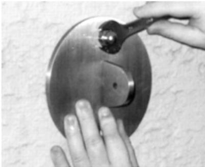
Bei der Befestigung der Komponenten CL01 und CL02 sind je nach Art der Gebäudewand, die entsprechenden Befestigungsmittel, z.B. Sicherheitsanker, Verbundanker oder Injektionsdübel nach Herstellerangaben einzusetzen.
